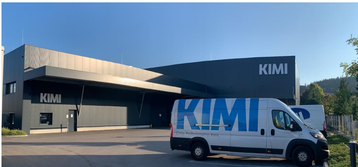
Slika 4: Novo visokoregalno skladišče.
